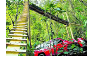
Figura 210 ▲ Paso de fauna instalado en la vía El Escobero, Envigado. Fotografía: Guillermo Ossa (2016).
