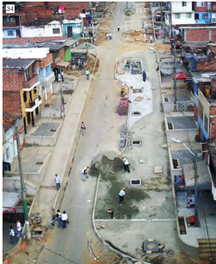
Imagen 34: Proceso de intervención en la calle 107, futuro Paseo Andalucía. Fuente: EDU, 2005.
