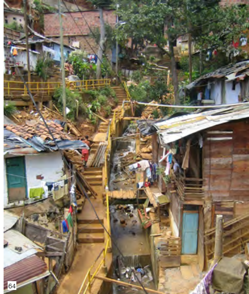
Imagen 64: Condiciones de precariedad ambiental y físico espacial en la quebrada Juan Bobo antes de la intervención
