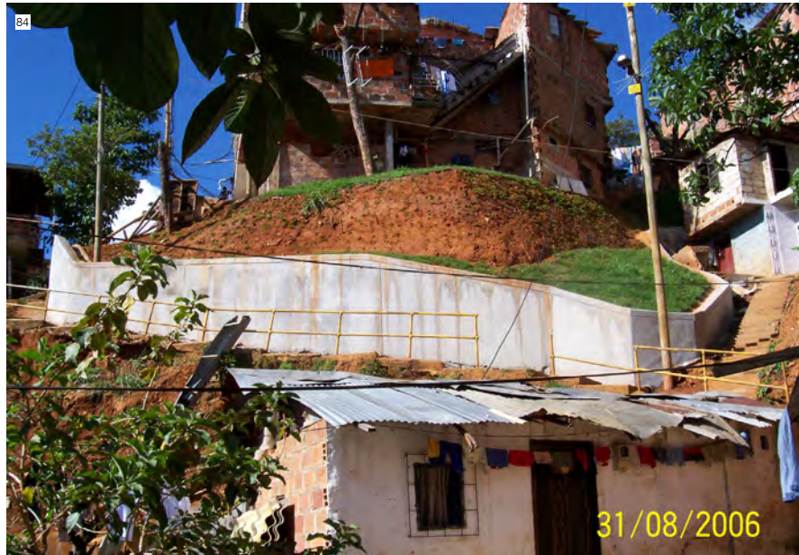
Imagen 84: Muros de contención asociados a la conformación del espacio público. Con el objetivo de conformar el espacio público se construyeron obras de mitigación financiadas por la autoridad ambiental de Medellín y su área metropolitana.
