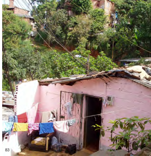
Imagen 83: Viviendas vulnerables a deslizamientos. En la época de lluvias las viviendas asentadas en la quebrada Juan Bobo eran vulnerables a deslizamientos debido al manejo inadecuado de los taludes y de las aguas lluvias.
