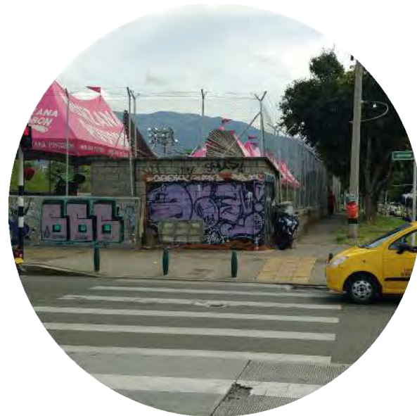
Figura 243 ▲ Estado actual cerramiento Pista Challenger Fuente: fotografía Archivo urbam EAFIT, 2017
