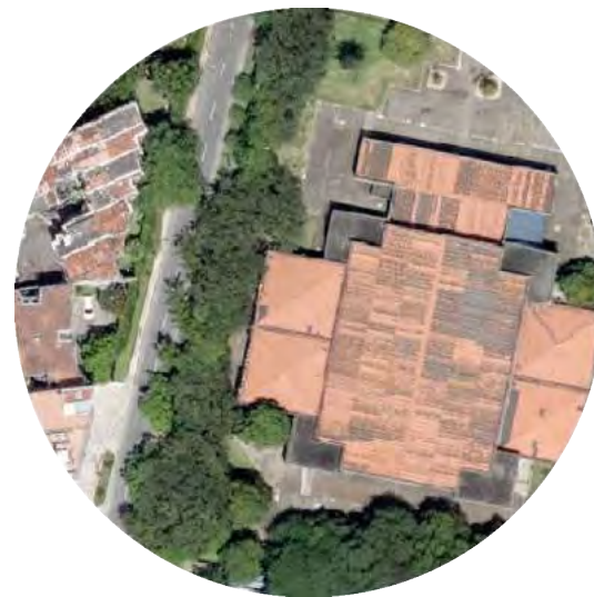
Figura 275 ▲ Costado occidental Coliseo Carlos Mauro Hoyos carrera 69B Fuente: Ortofotos de Medellín 2004-2016 (s. f.)
