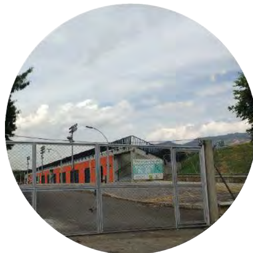
Figura 280 ▲ Acceso calle 30 Pista de Supercross BMX Mariana Pajón Fuente: fotografía Archivo urbam EAFIT, 2017
