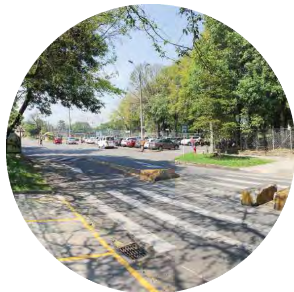
Figura 253 ▲ Cruce peatonal carrera 66B acceso principal Unidad Deportiva de Belén Fuente: fotografía Archivo urbam EAFIT, 2017
