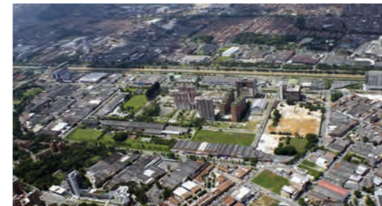
▲ Sector en transformación. Fuente: Valores Simesa.
