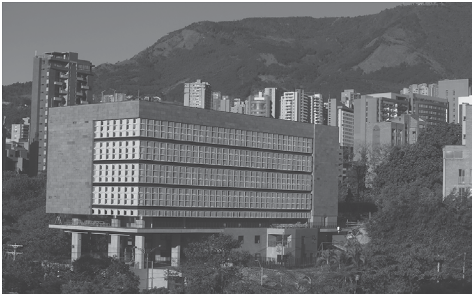
El bloque 1 de Idiomas EAFIT resalta en el sector de El Poblado por su estructura innovadora
